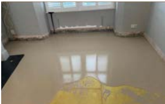
Then pour the levelling compound...
